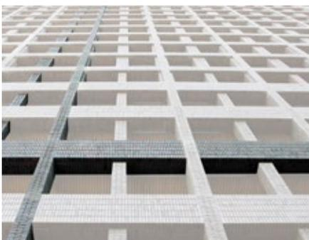
Fassade aus Backsteinfertigteilen
